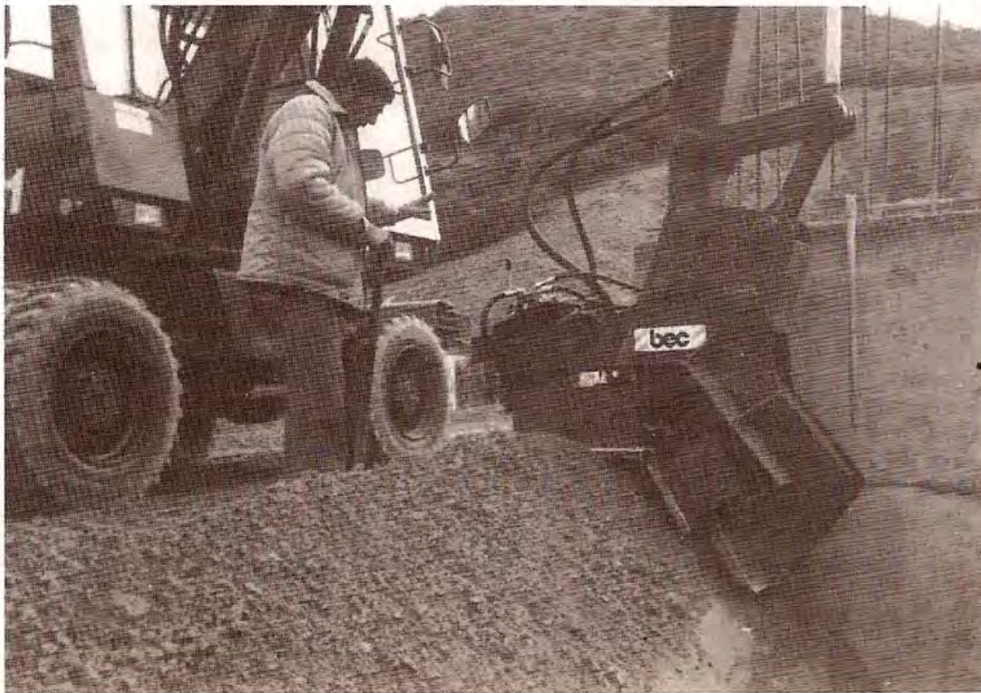
ΜΗΧΑΝΙΚΗ ΣΥΜΠΥΚΝΩΣΗ ΤΟΥ ΠΡΑΝΟΥΣ ΦΡΑΓΜΑΤΟΣ
