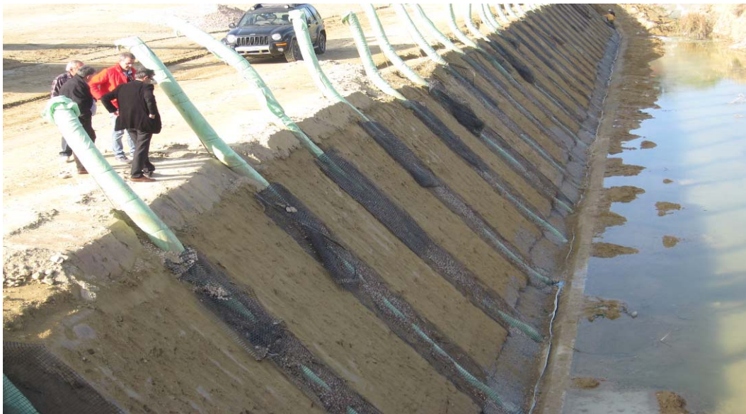
Εικόνα 7: Φράγμα Ληθαίου Τρικάλων, εγκιβωτισμός σωλήνων αποστράγγισης με χαλίκια, γεωύφασμα και γεώπλεγμα.
