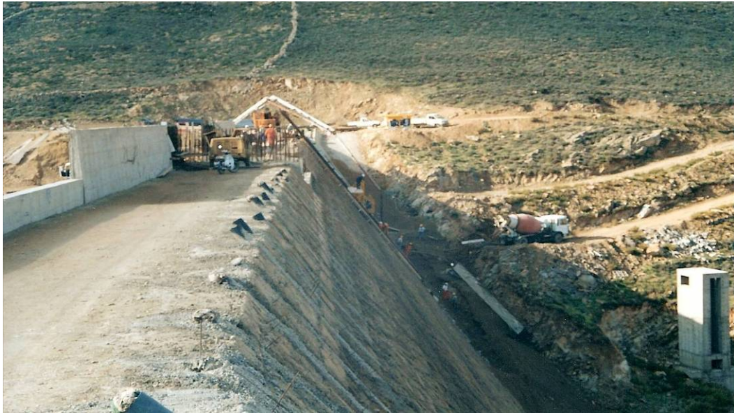
Εικόνα 6: Φράγμα Στενό Σερίφου, εγκιβωτισμός σωλήνων αποστράγγισης με πορώδες σκυρόδεμα.
