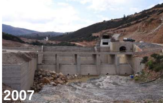
Λεκάνη ηρεμίας υπερχειλιστή
