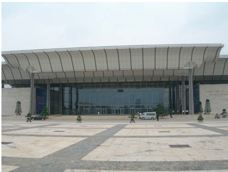
Φωτογραφία 4 : Εξωτερική άποψη Συνεδριακού Κέντρου
