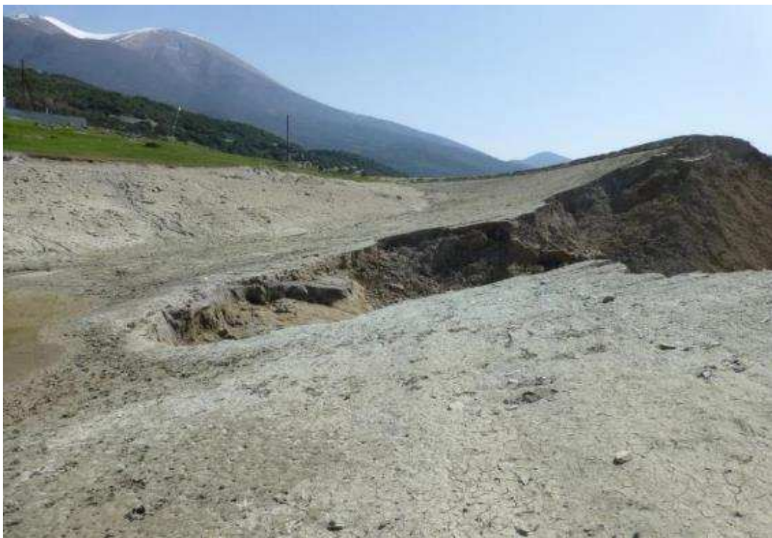
Φωτογραφία 19. Φράγμα Σπαρμού. Η ανάντη περιοχή του καναλιού θραύσης.
