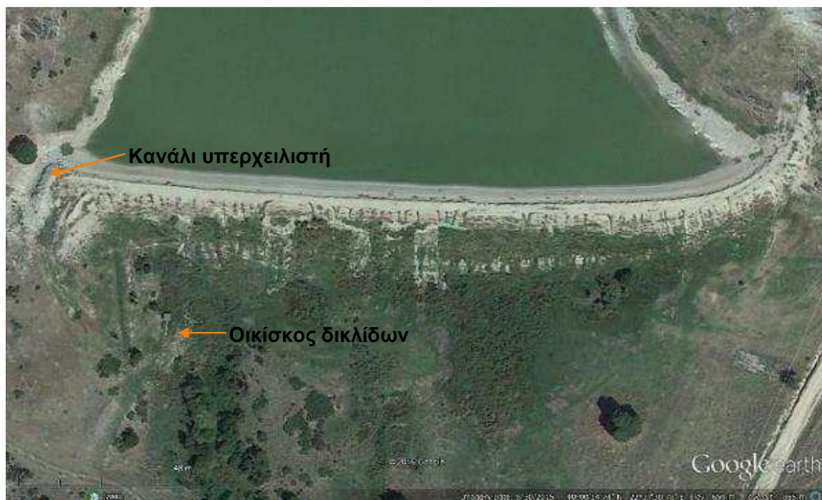
Φωτογραφία 4. Το Φράγμα Παλαιοχώρας Σπαρμού (Google Earth, 30/8/2015). Εμφανείς οι ολισθήσεις και νεροφαγίες στο κατάντη πρνανές
