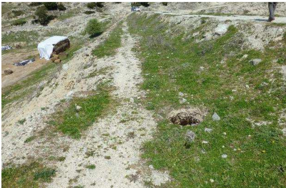
Φωτογραφία 38. Φράγμα Παλαιομονάστηρου Καλυβίων.
