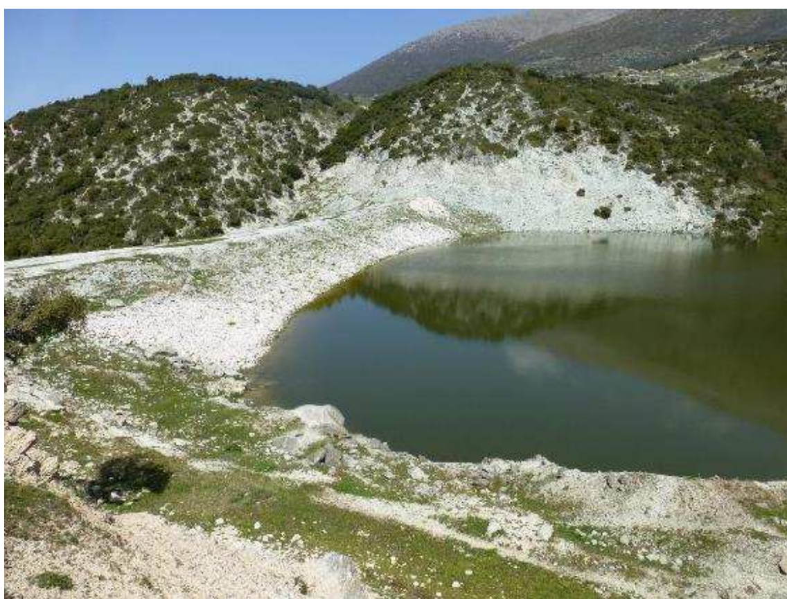
Φωτογραφία 42. Φράγμα στη θέση Γκαγκσές Καλυβίων. Η ανάντη παρειά και ο ταμιευτήρας.
