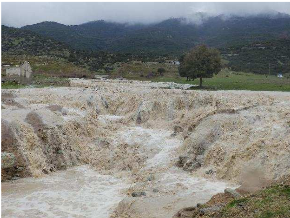
Φωτογραφία 8. Φράγμα Παλαιοχώρας Σπαρμού – Φωτογραφία αμέσως κατάντη του φράγματος, προς το τέλος της θραύσης (Φωτογραφία Κώστας Κουτσιούκης, 27/3/2016, 12:40)
