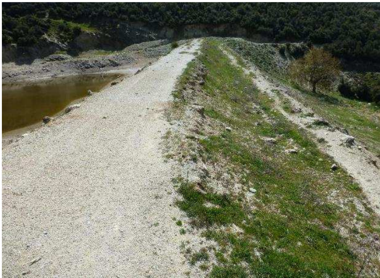
Φωτογραφία 35. Φράγμα Παλαιομονάστηρου Καλυβίων.
