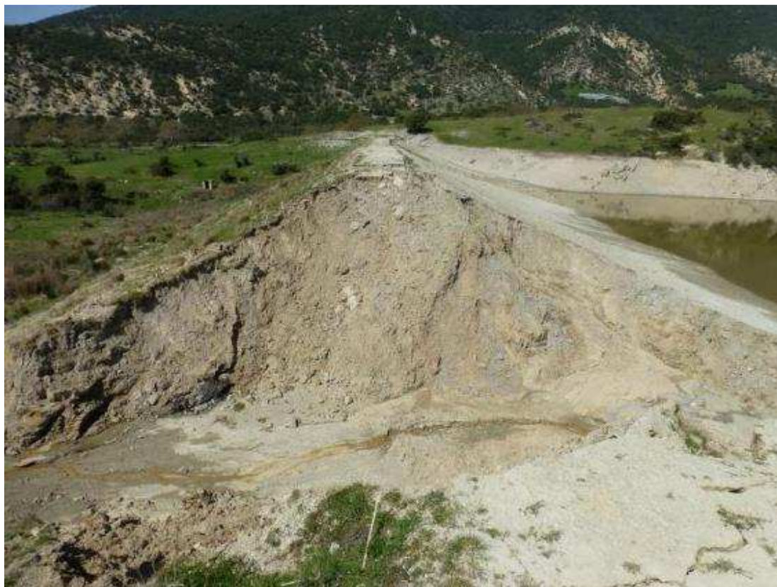
Φωτογραφία 14. Φράγμα Σπαρμού. Η δεξιά παρειά του καναλιού της θραύσης
