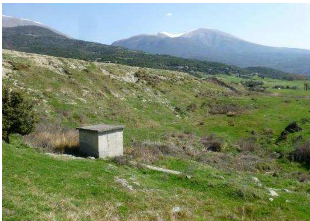
Φωτογραφία 25. Φράγμα Σπαρμού. Η κατάντη παρειά του φράγματος και ο οικίσκος δικλίδων.
