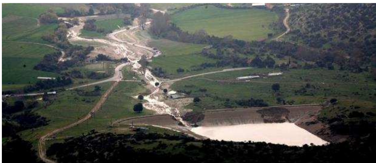
Φωτογραφία 9. Φράγμα Παλαιοχώρας Σπαρμού – Φωτογραφία μετά την ολοκλήρωση του φαινομένου και την ολίσθηση στο δεξιό άκρο του ανάντη πρανούς (Φωτογραφία: Eurokinissi 27/3/2016, 14:00 περίπου)
