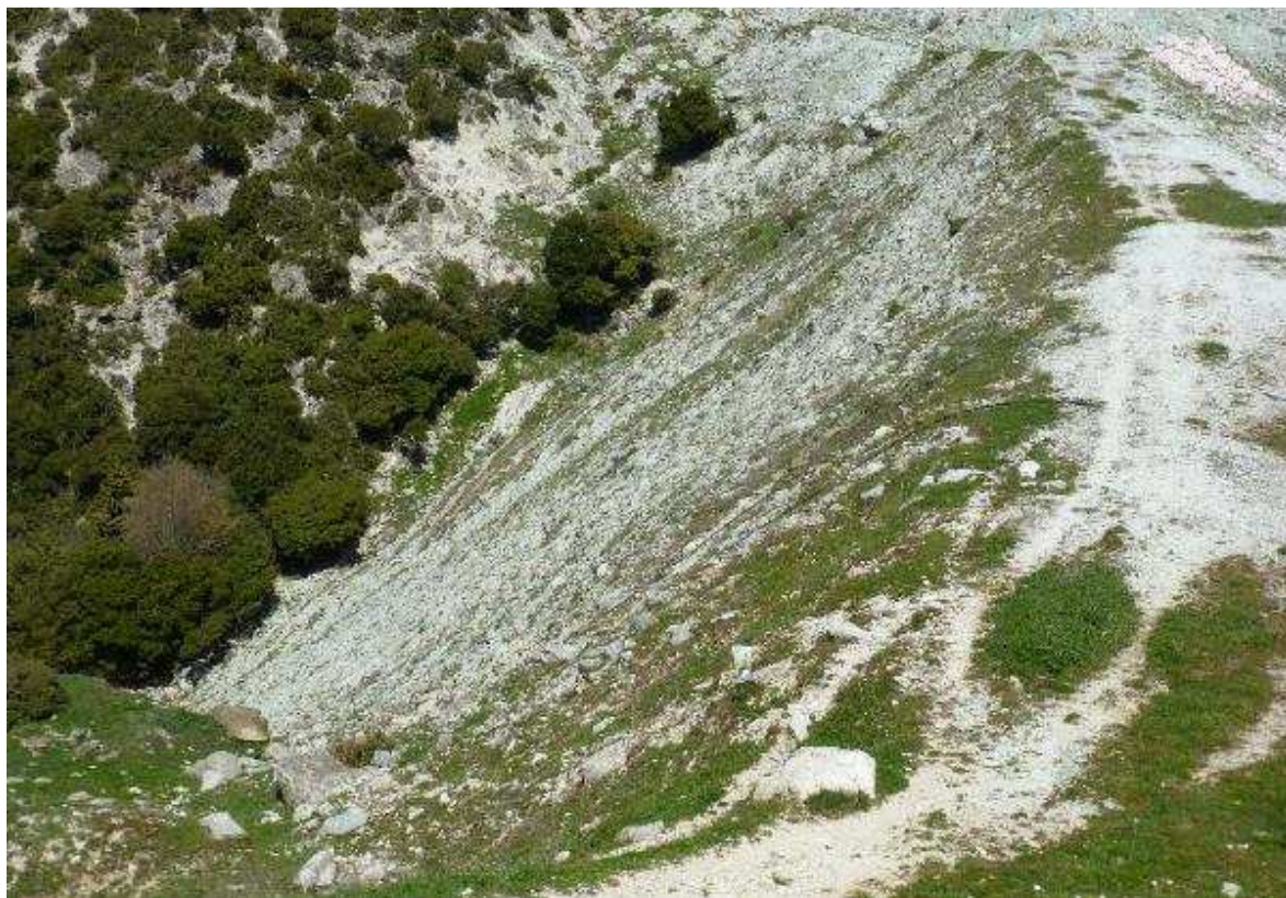
Φωτογραφία 43. Φράγμα στη θέση Γκαγκσές Καλυβίων. Η καπάντη παρειά.
