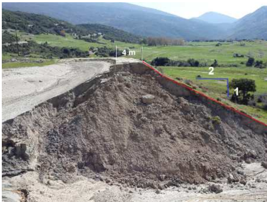
Φωτογραφία 15. Φράγμα Σπαρμού. Η αριστερή παρειά του καναλιού της θραύσης
