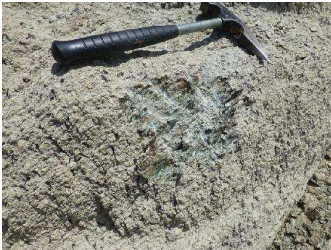
Φωτογραφία 28. Φράγμα Σπαρμού. Οι γενεύσεις του αριστερού αντερείσματος.
