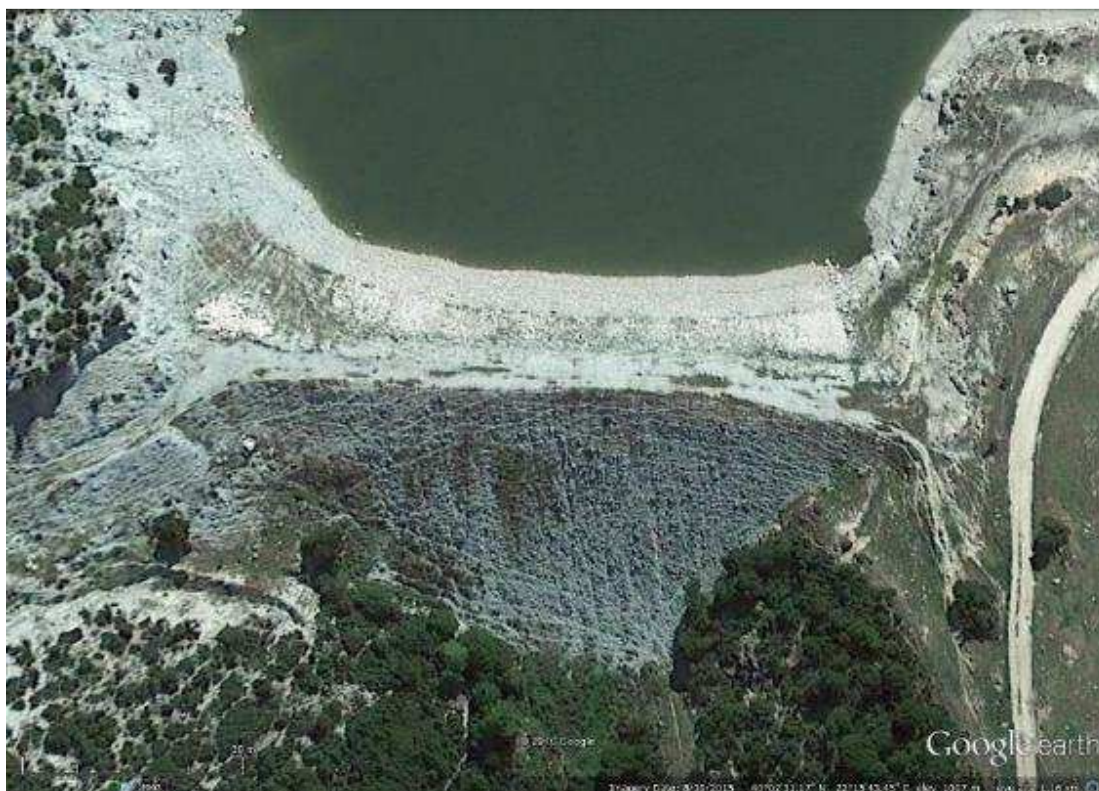
Φωτογραφία 40. Φράγμα στη θέση Γκαγκσές Καλυβίων.
