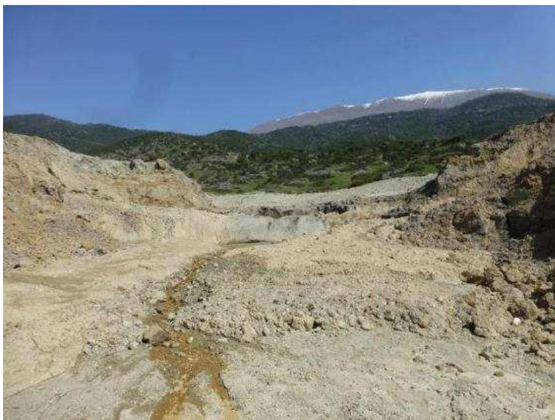
Φωτογραφία 17. Φράγμα Σπαρμού. Ο πυθμένας του καναλιού της θραύσης προς ανάντη.
