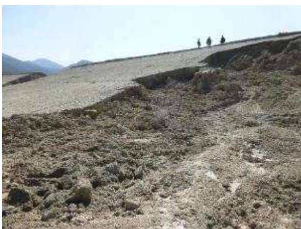
Φωτογραφία 30. Φράγμα Σπαρμού. Απόψεις της ανάντη ολίσθησης.
