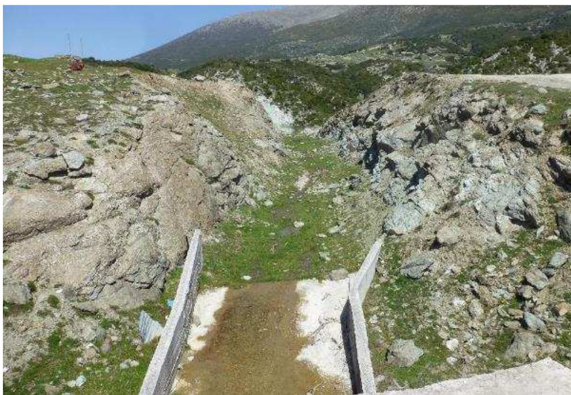
Φωτογραφία 44. Φράγμα στη θέση Γκαγκσές Καλυβίων. Το καπάντη άκρο του καναλιού του υπερχειλιστή. Στο βάθος ο ταμιευτήρας.
