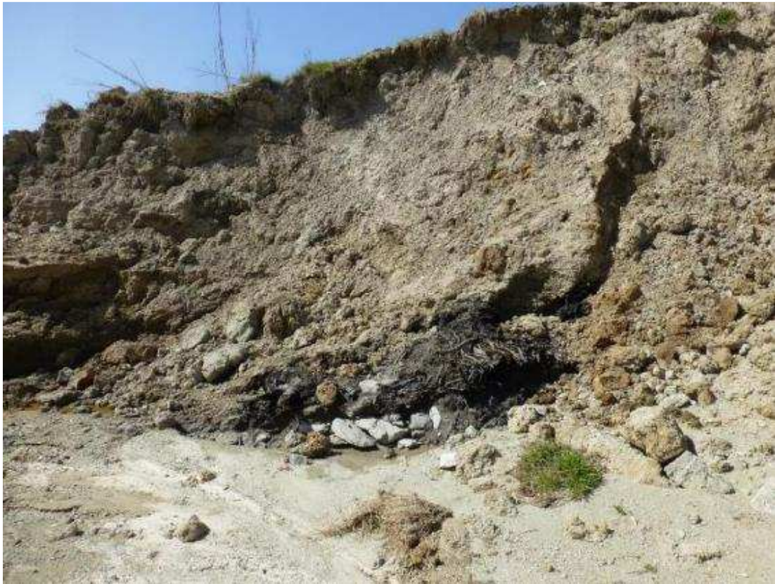
Φωτογραφία 18. Φράγμα Σπαρμού. Η δεξιά παρειά του καναλιού θραύσης. Διακρίνονται ενσωματωμένα ξύλα στο επίπεδο θεμελίωσης
