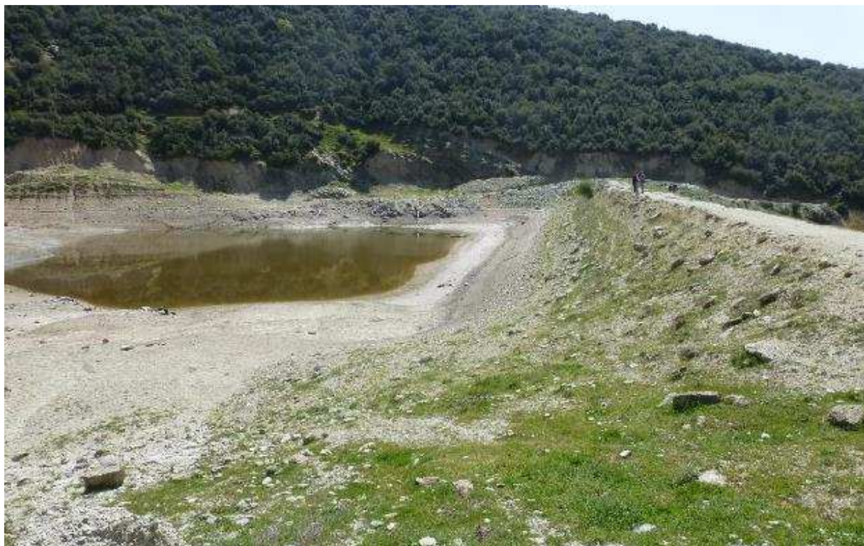
Φωτογραφία 36. Φράγμα Παλαιομονάστηρου Καλυβίων.
