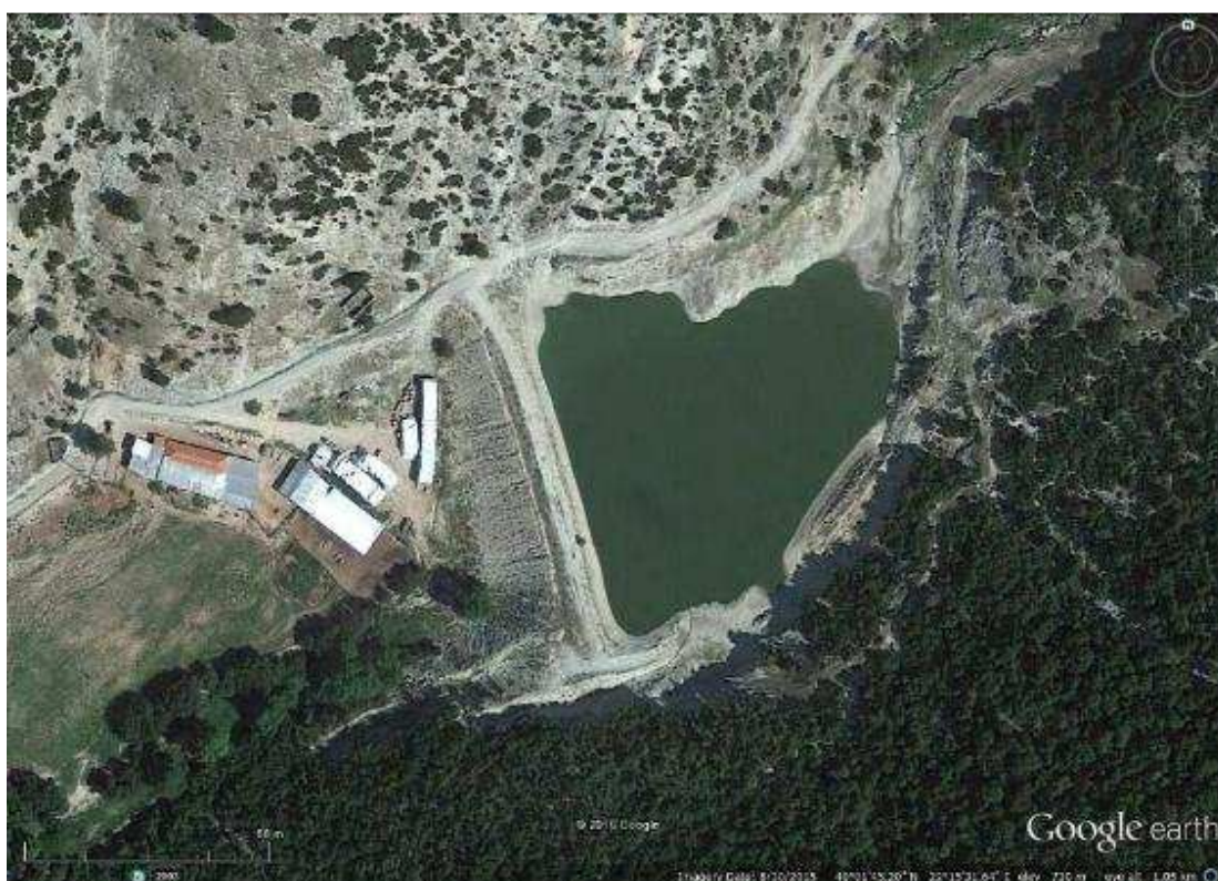
Φωτογραφία 32. Φράγμα Παλαιομονάστηρου Καλυβίων. Άποψη ταμειευτήρα 30/8/2015.
