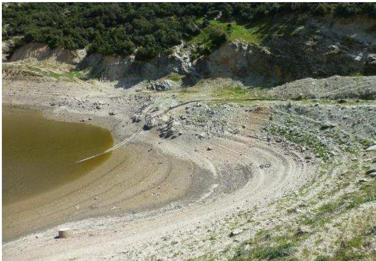
Φωτογραφία 37. Φράγμα Παλαιομονάστηρου Καλυβίων.
