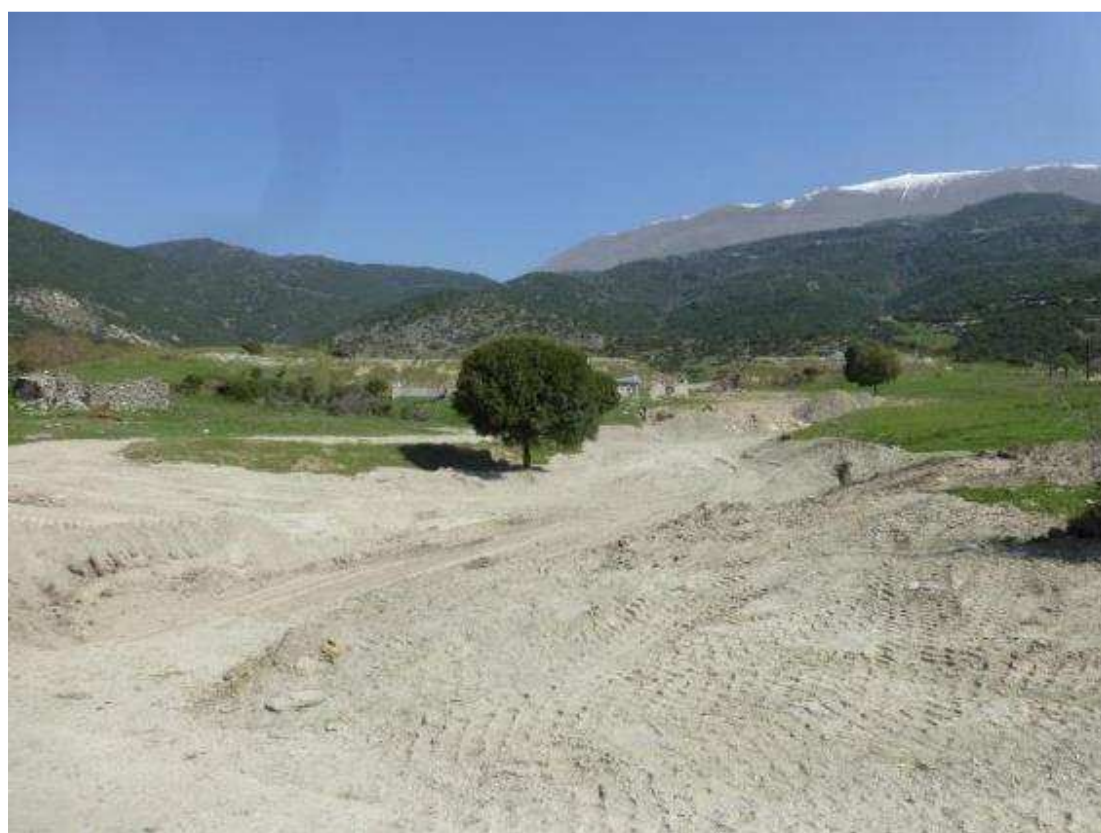
Φωτογραφία 11. Φράγμα Σπαρμού. Αποθέσεις υλικών κατάντη του φράγματος μετά τη θραύση
