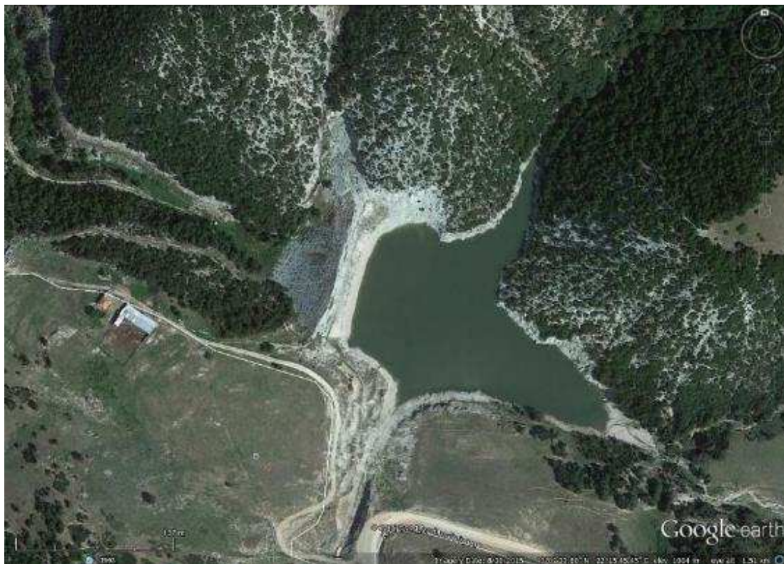
Φωτογραφία 39. Φράγμα στη θέση Γκαγκσές Καλυβίων.
