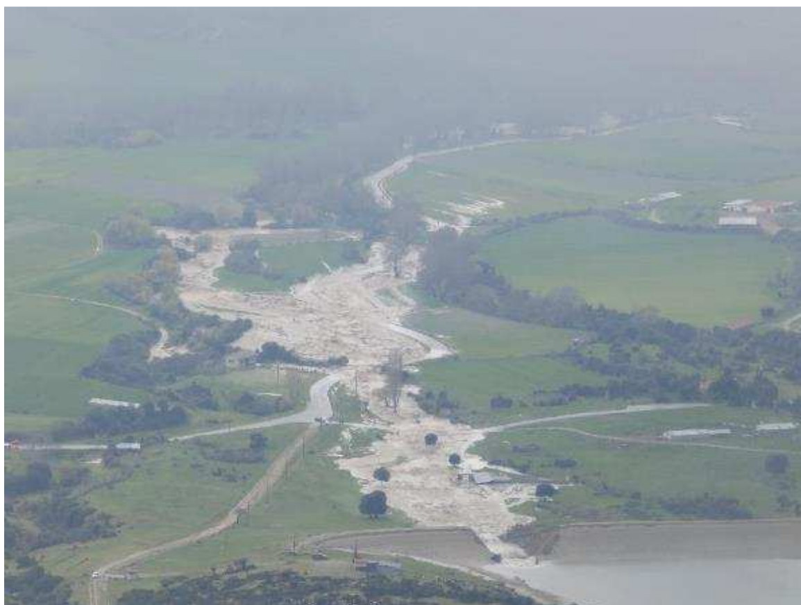
Φωτογραφία 5. Φράγμα Παλαιοχώρας Σπαρμού – Φωτογραφία προς το τέλος της θραύσης με σημαντική ακόμη πλημμυρική παροχή. Δεν έχει ακόμη συμβεί η ολίσθηση στο δεξιό άκρο του ανάντη πρνανούς (Φωτογραφία Κώστας Κουτσιούκης, 27/3/2016, 12:21)
