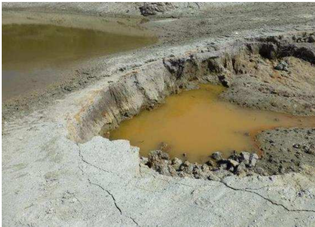
Φωτογραφία 20. Φράγμα Σπαρμού. Αναβαθμός στο ανάντη άκρο του καναλιού θραύσης.
