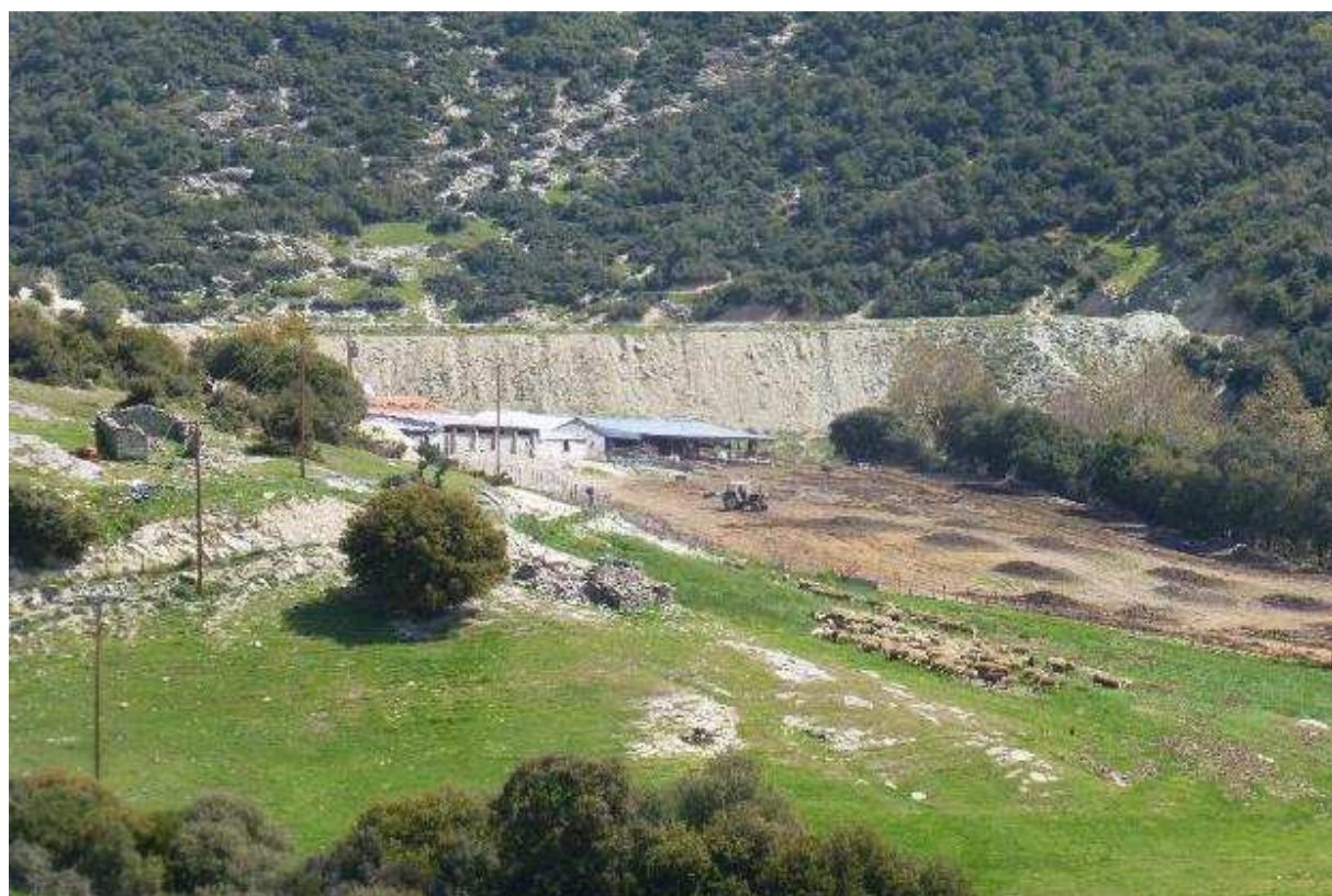
Φωτογραφία 34. Φράγμα Παλαιομονάστηρου Καλυβίων.
