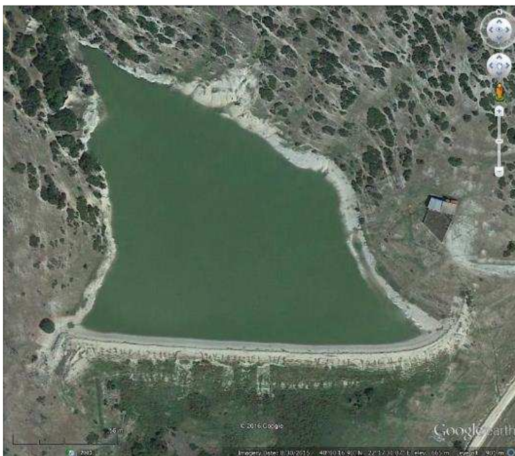
Φωτογραφία 2. Αποψη ταμιευτήρα Παλαιοχώρας Σπαρμού (Google Earth, 30/8/2015)
