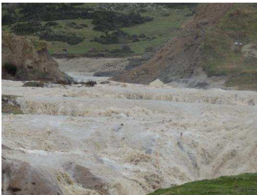
Φωτογραφία 7. Φράγμα Παλαιοχώρας Σπαρμού – Φωτογραφία αμέσως κατάντη του φράγματος, προς το τέλος της θραύσης (Φωτογραφία Κώστας Κουτσιούκης, 27/3/2016, 12:35)
